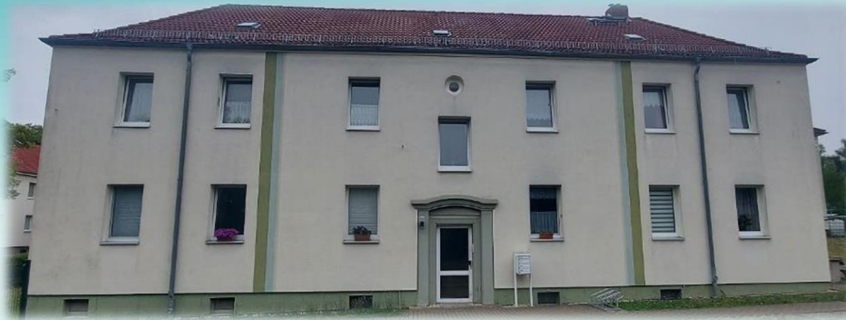
malermäßige Instandsetzung der Fassade Robert-Koch-Straße 4
