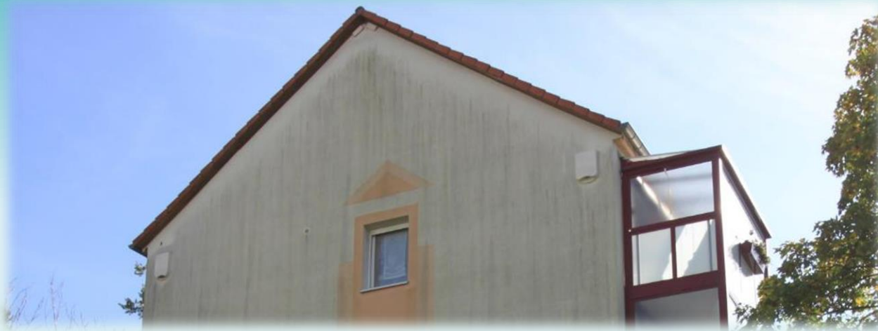
Artenschutzmaßnahmen im Zuge von Fassadensanierungen Gerhart-Hauptmann-Straße
